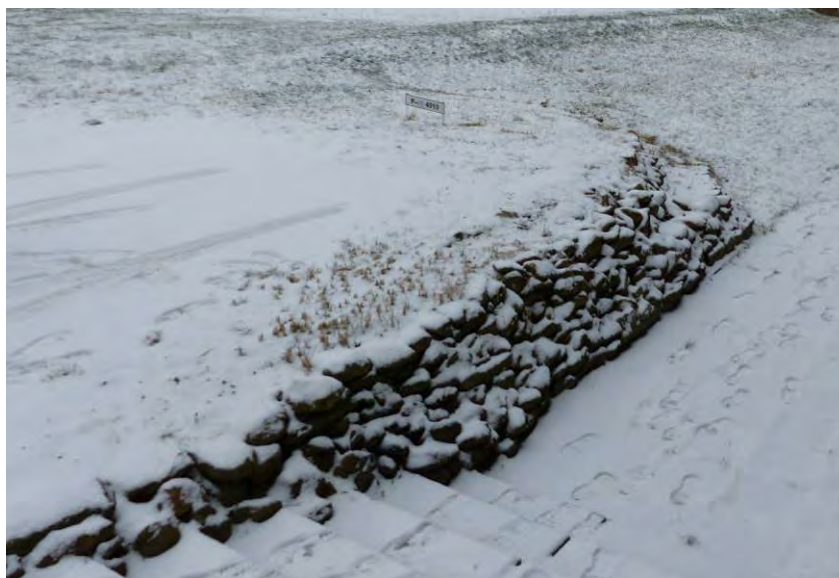
Abb. 23: Trockenmauer an der Werkstatt
