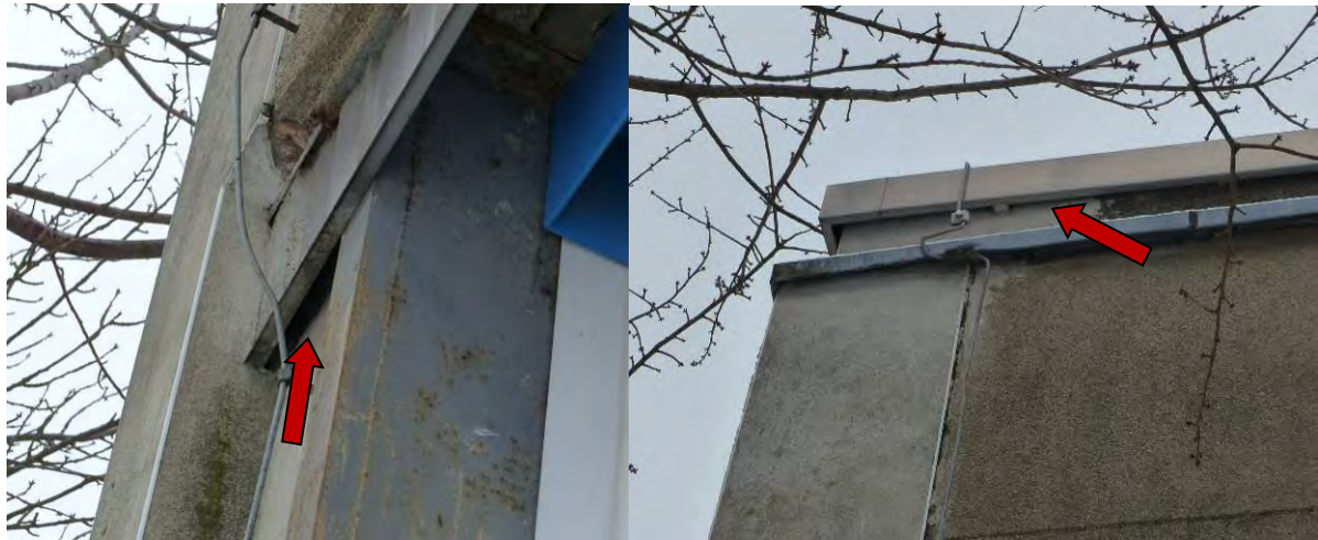
Abb. 22: Potentielle Habitate in Spalten unter den Dachblechen (rechts) und sonstigen Blechverkleidungen (links) der Werkstatt
