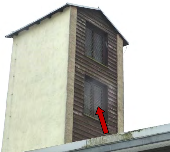
Abb. 17: Potentielle Habitate hinter der Jalousie des Turmes
