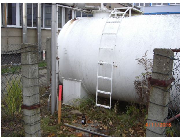
Bild 5: ALVF 003- oberirdischer Heizöltank: Blick nach NW auf den Bohransatzpunkt der KRB 1/16.
