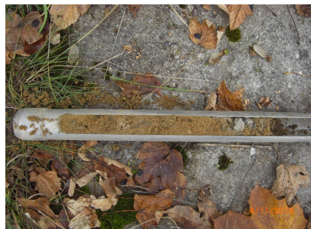
Bild 6: Detailaufnahme KRB 1/16. Die Betonmächtigkeit beträgt 15 cm.
