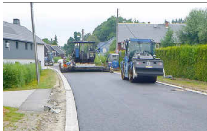
Asphalteinbau am 1. Juli 2026
